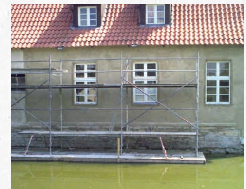
Sanierung Wasserschloss 2008 mit aerodurit® EP2010
